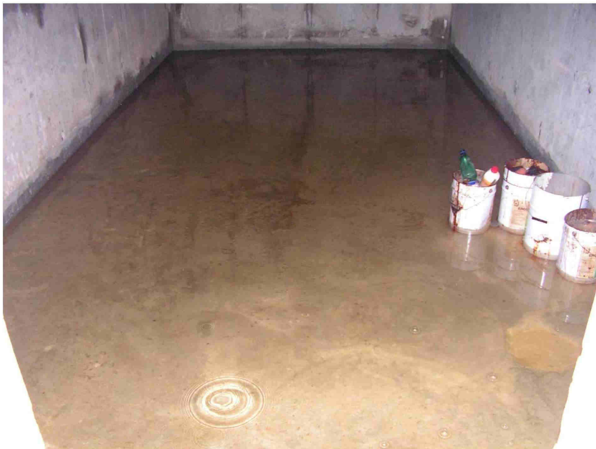
Podivín - II. Etapa výstavby podchodu nebyla dokončena a tato část je trvale pod vodou
