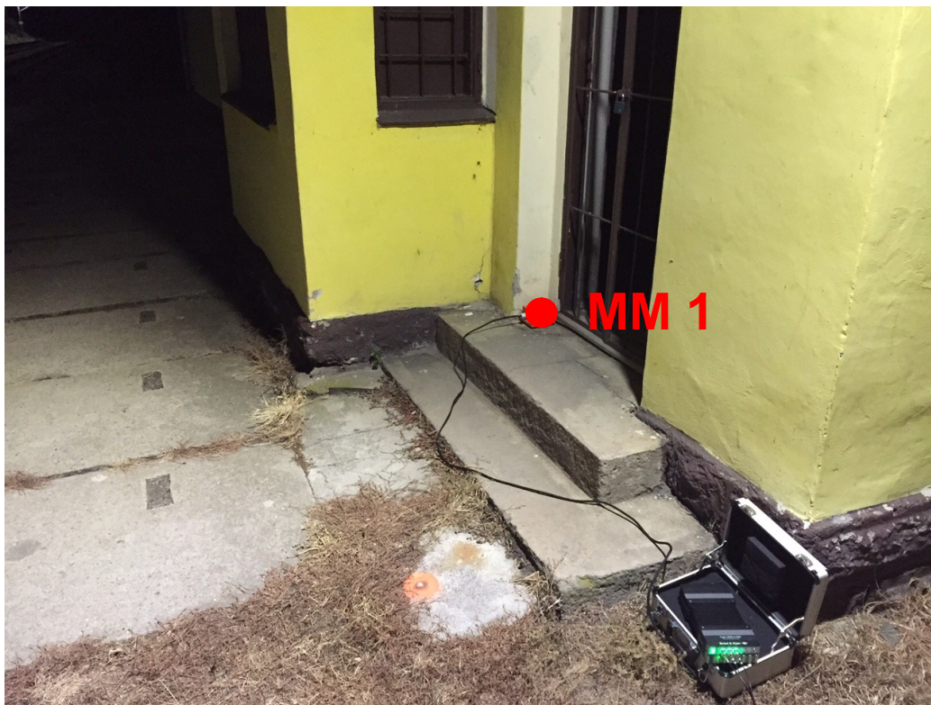
Místo měření č. 1: Umístění snimače vibrací
