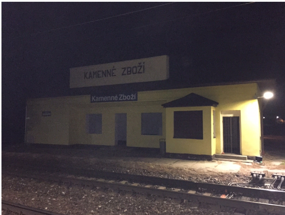
Místo měření č. 1: železniční zastávka Kamenné Zboží
